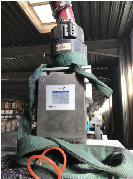
Eisenvorabscheidung mit patentierten Neodym Magnet DN auf Digital2 VA 100
